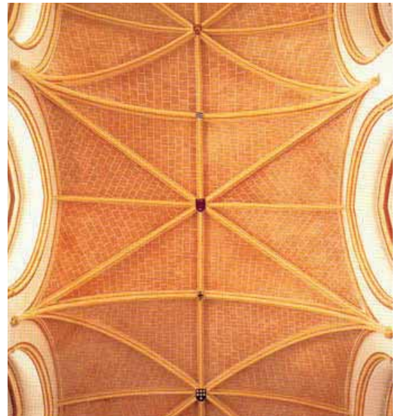
Nervures des voûtes de la nef.
