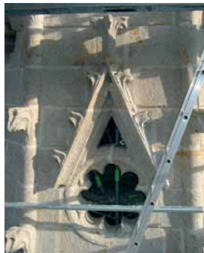
Nettoyage et restauration de la maçonnerie de la flèche Nord
