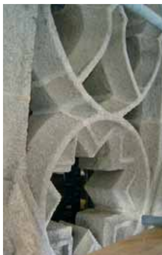
Nettoyage et restauration de la maçonnerie de la flèche Nord
