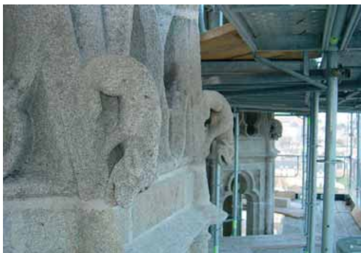
Restauration des sculptures de la tour Nord
